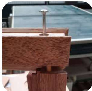
Mécanique (tourillons + vis) (Dormants gamme Euro, Auvergne et bois alu)
