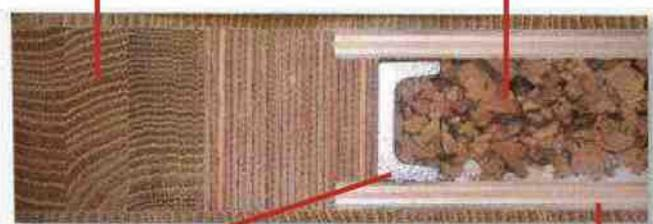
Isolant mousse PU acermi 35 kg/m<sup>3</sup>, Liège
